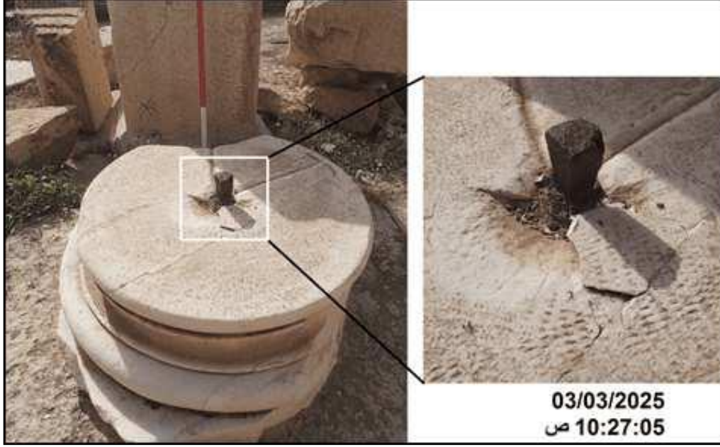
شكل (19): صورة توضح الأضرار الذي سببها استخدام الحديد في ترميم احدى قواعد الأعمدة الرُخامية في السوق السيفيري بمدينة لبة، وذلك بتعشّم منتصف القاعدة نتيجة صدأ الحديد. (تصوير الباحثان).
