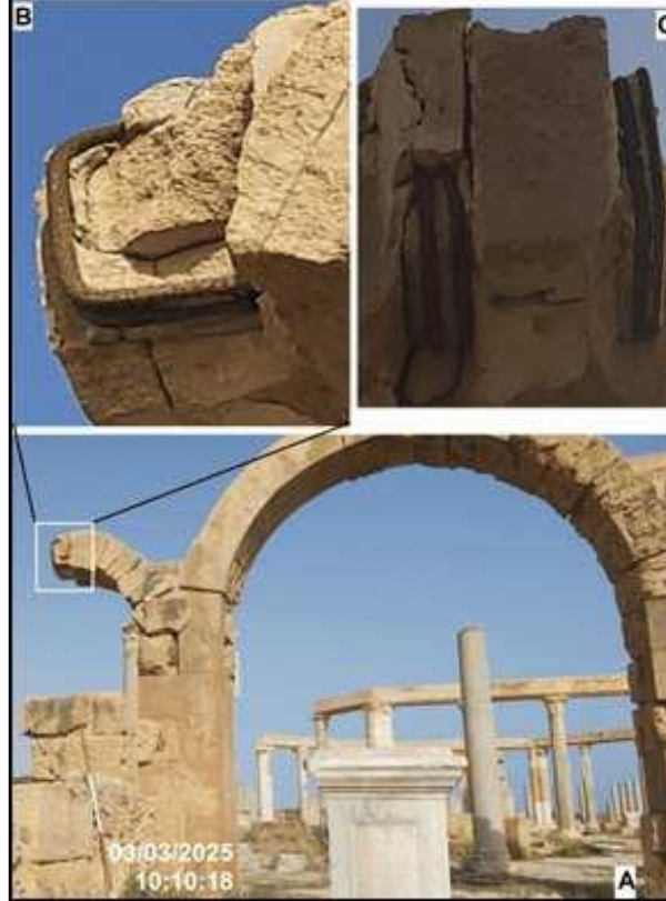
شكل (20): الصورة A توضح الترميم الخاطيء في تثبيت حجارة العقد الأيسر للمدخل الشرقي للسوق البوني باستخدام أسياخ الحديد، والصورة B و C توضح تعشّم حجارة العقد نتيجة صدأ أسياخ الحديد. (تصوير الباحثان).
