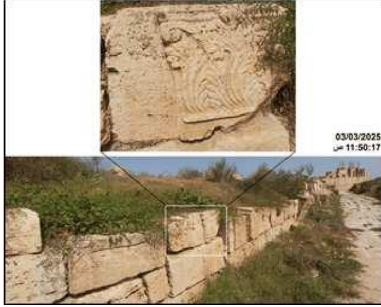
شكل (29): صورة توضح إعادة بناء خاطئة لأحد الجدران في الطريق المؤدي لمسرح المدينة، وذلك بوضع قطعة حجرية منحوتة بزخرفة بيزنطية في غير مكانها. (تصوير الباحثان).
