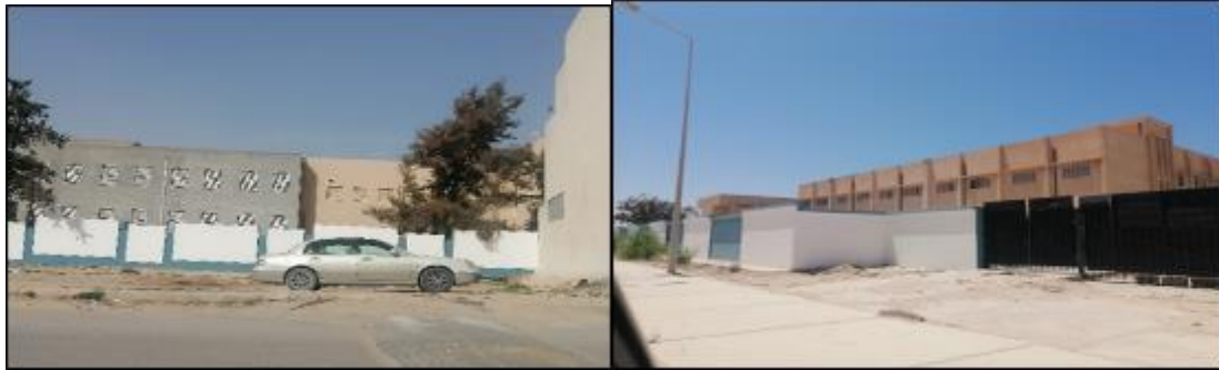
صورة (7) إختلاف لون طلاء المباني المصدر: عدسة الباحثان بمنطقة (عباد، الجزيرة)
