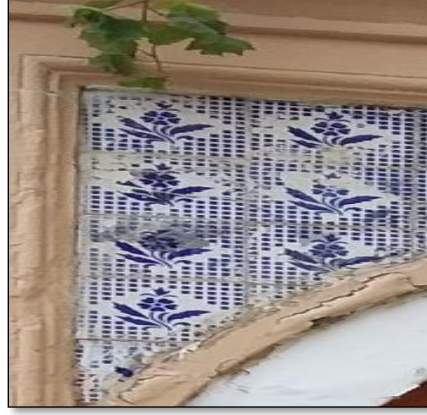
شكل (12): زخرفة القاشاني في كوشتي عقد مدخل جامع النخلي المصدر (تصوير الباحثان).
